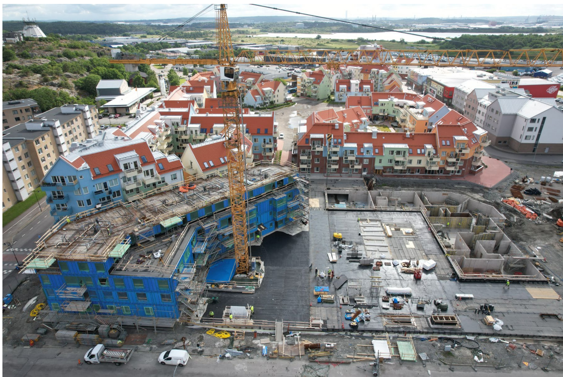
Figur 4: Foto över pågående byggnation inom planområdet (Amhult 2, 2024)
